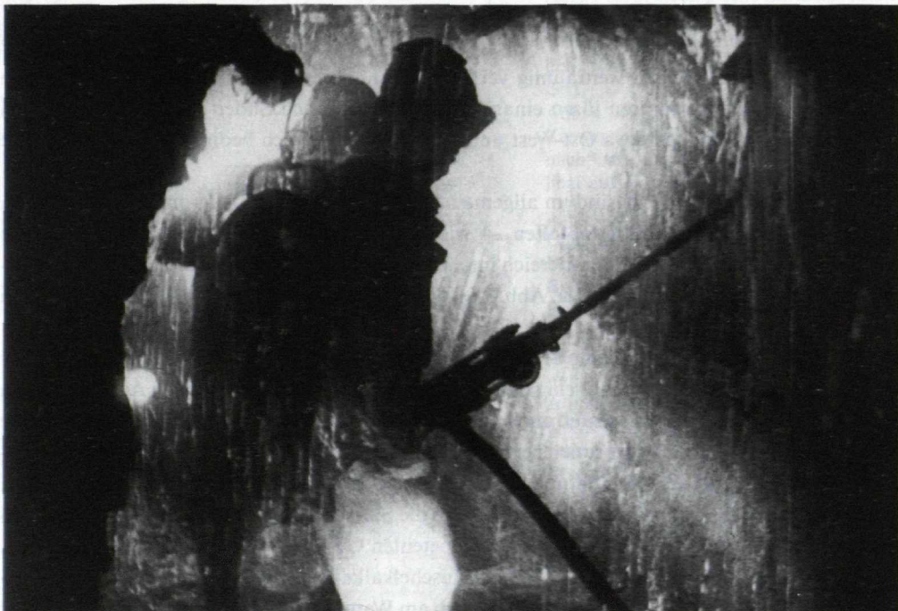
Stollenvortrieb im Rumer Stollen/Abzweigung IV bei starkem Wasserandrang (Foto 2)
