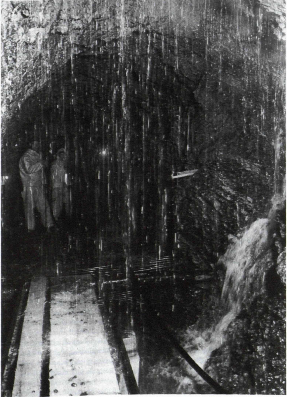
Wasserandrang im Rumer Stollen in den Gesteinen des Alpinen Muschelkalks bei Station 479.00, etwa 26 Meter vor dem großen Verbruch (Foto 3)
